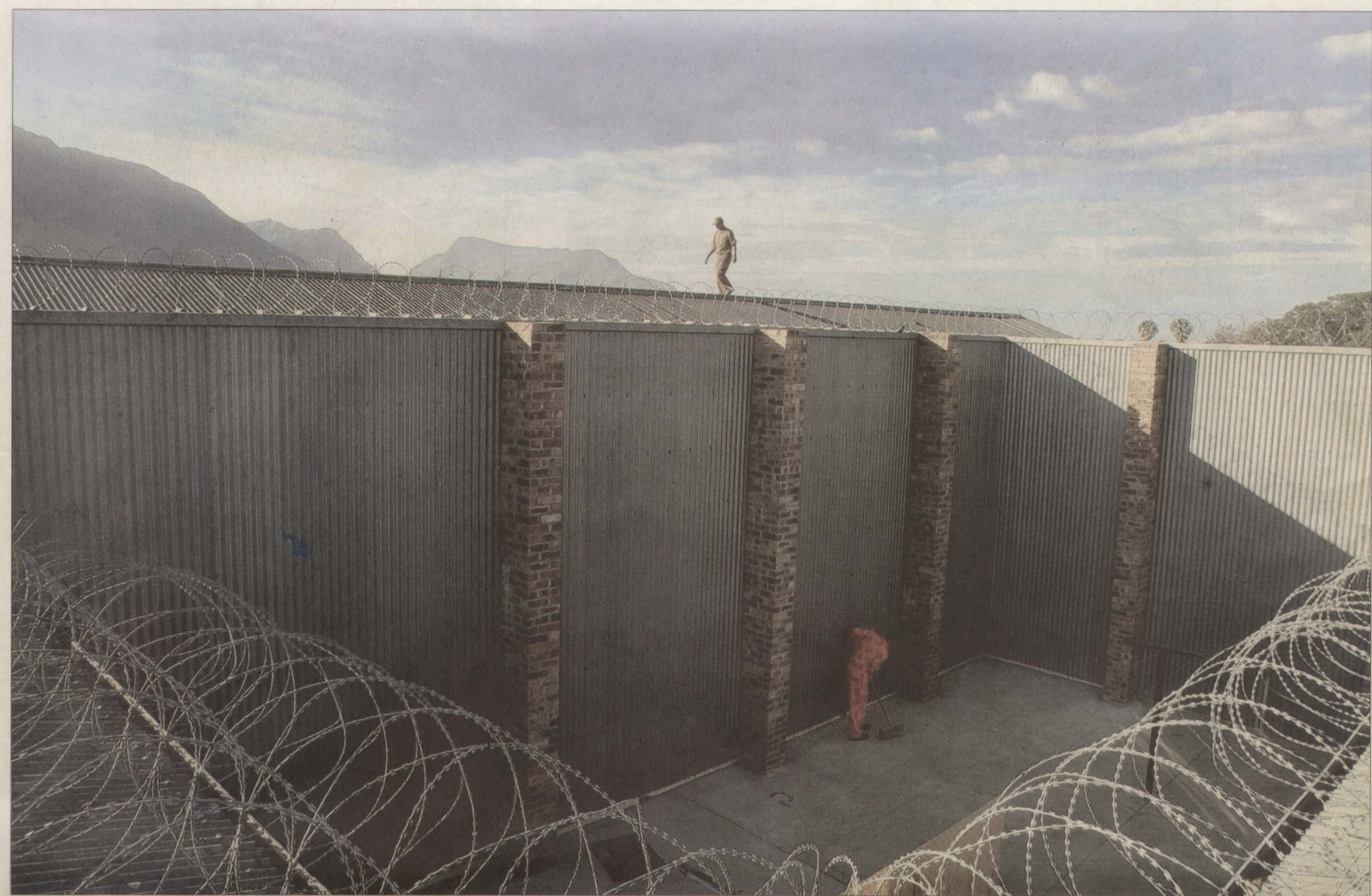
Voorberg, eines der ältesten Gefängnisse Südafrikas. Im Aluminiumbau sind die Gefangenen auch den Extremen des Wetters ausgesetzt: Im Winter ist es eiskalt, im Sommer glühend heiss.
