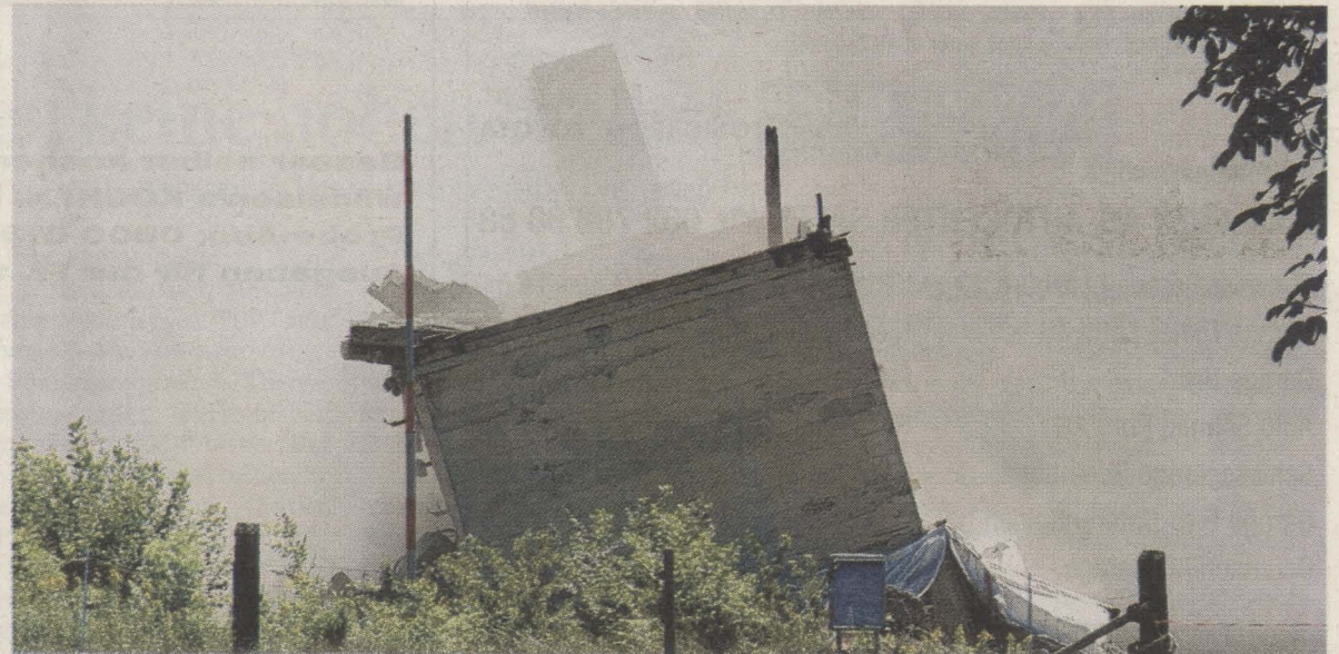
Die Gebäudeüberreste flogen nicht in Einzelteile zerlegt durch die Luft, sondern neigten sich wie beabsichtigt zur Seite.
