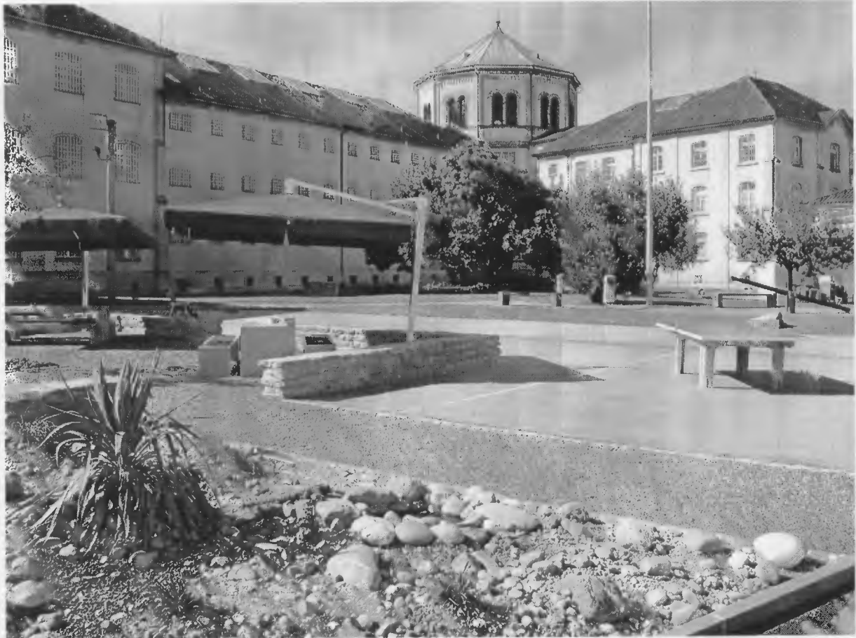
Die Strafanstalt Lenzburg im Wandel: Der Besucherfreiplatz konnte dank der Stiftung Weihnachtsskasse der Strafanstalt Lenzburg neu gestaltet werden. Demnächst werden die Dächer saniert.
