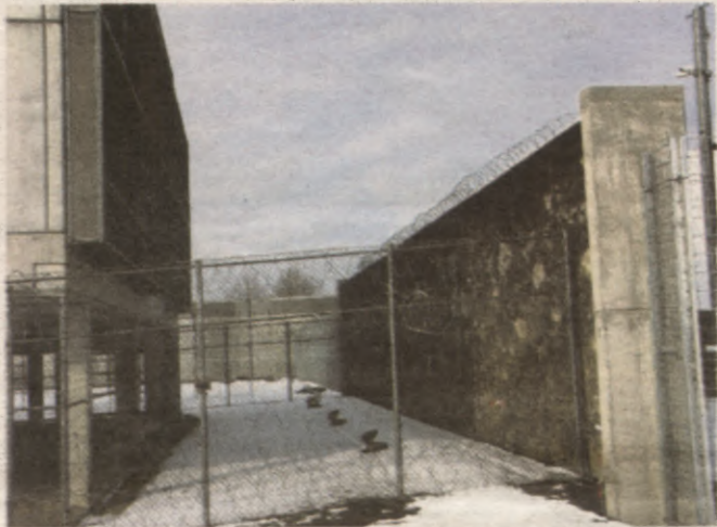
Von der 140 Jahre alten Mauer bleibt ein Stück (rechts) erhalten. HH.
