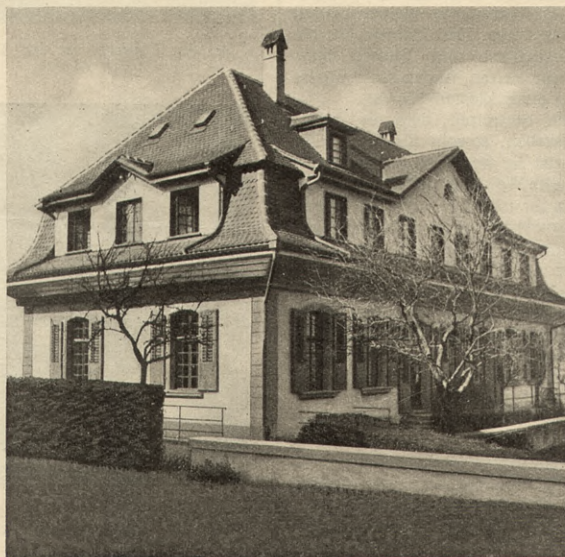
Oben: Die Liegenschaft, von Osten gesehen. / Rechts: Blick von Westen auf das Wohnhaus. Neu erstellt wurden das erste Stockwerk und das Dachgeschoss.
