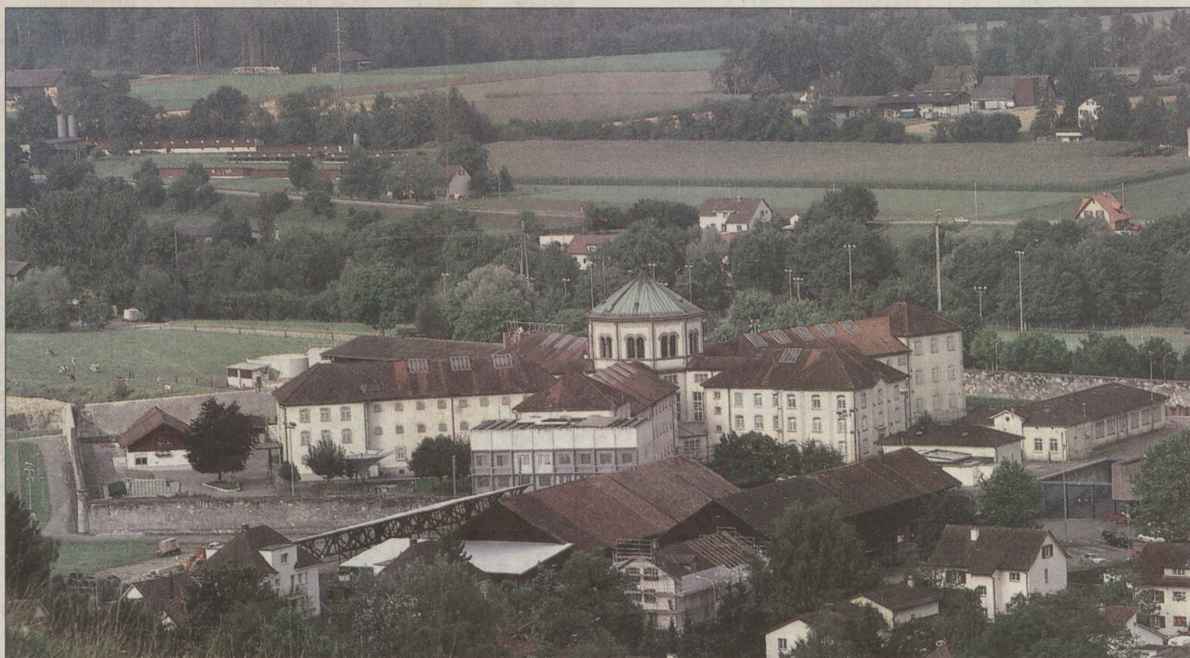
«Fünfstern» Die abbruchreife 4,5 bis 5 Meter hohe Mauer um die Strafanstalt Lenzburg soll durch 6 bis 7,5 Meter hohe Betonelemente ersetzt werden.
