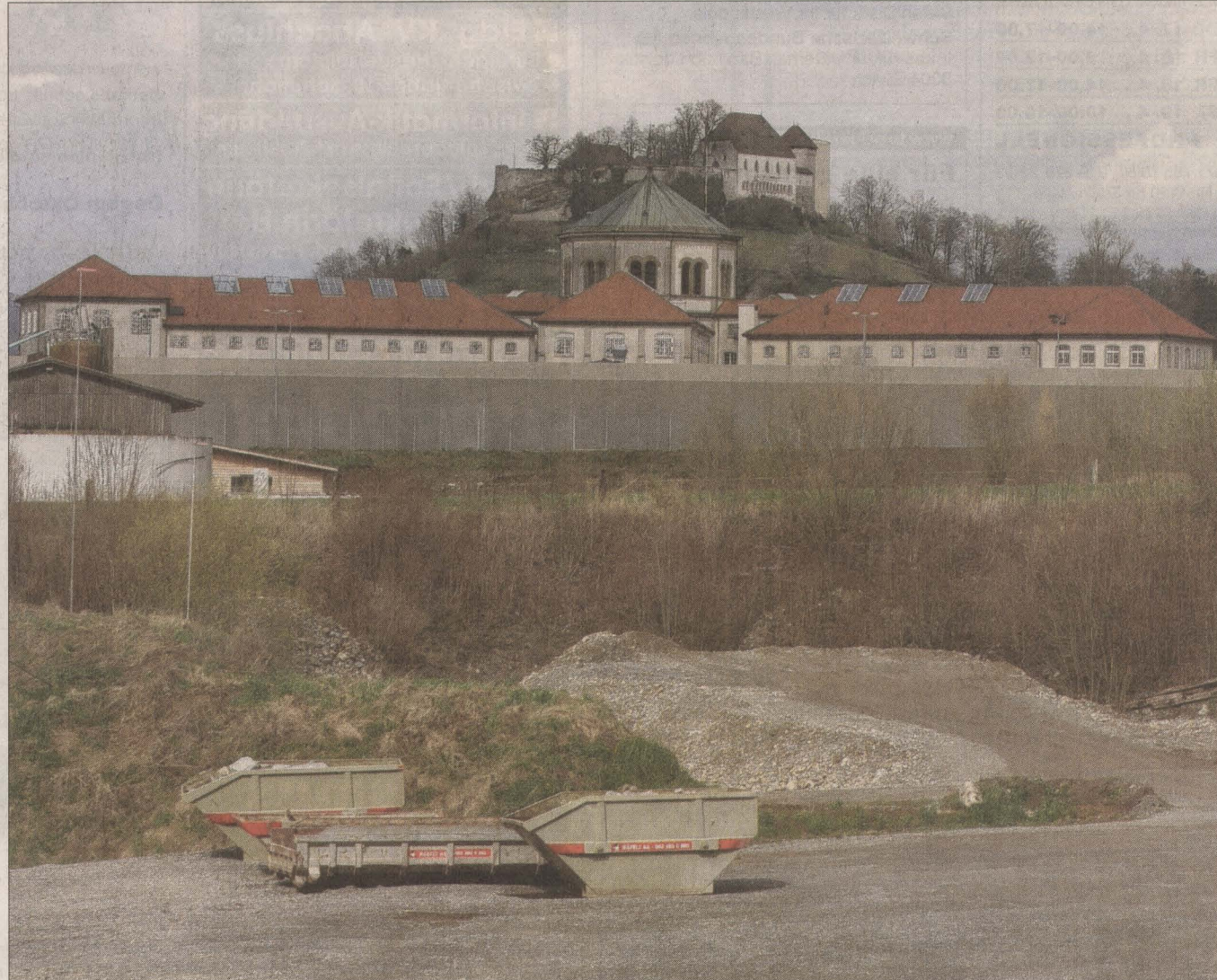
KIESGRUBE Hier soll im kommenden Herbst mit dem Bau des Zentralgefängnisses begonnen werden. ALOIS FELBER
