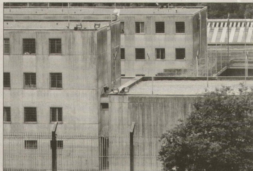
Innen nicht ganz so, wie man von aussen meinen würde: der Gefängnisbau.
