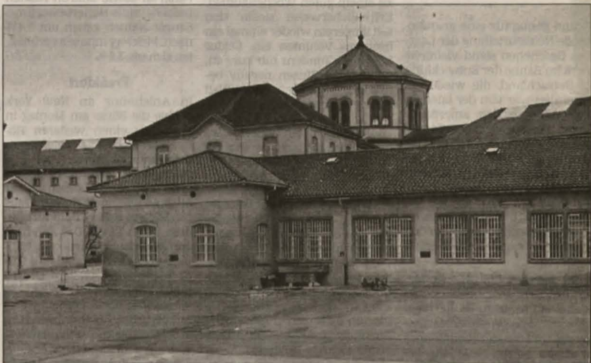
Soll sicherer werden: Die Strafanstalt Lenzburg, drittgrösste geschlossene Vollzugsanstalt der Schweiz. Foto: key
