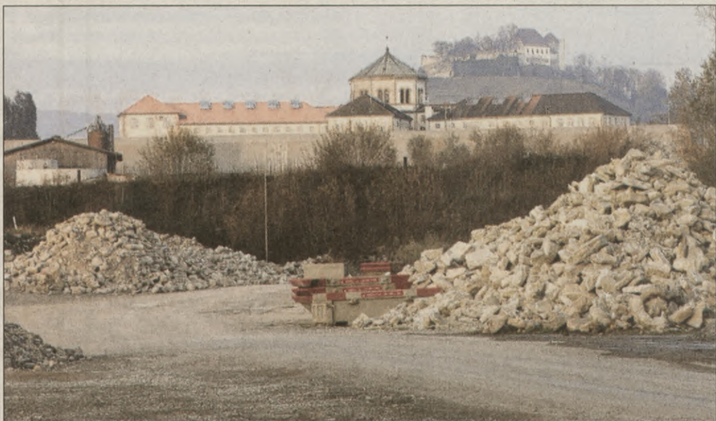
KIESGRUBE Hier entsteht das neue Zentralgefängnis des Kantons Aargau. ALOIS FELBER
