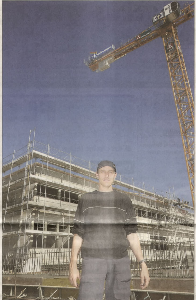
KNAST WEGEN PLAKAT? Grossrat Pascal Furer posiert schon mal vor der Baustelle des Zentralgefängnisses in Lenzburg. EMANUEL FREUDIGER
