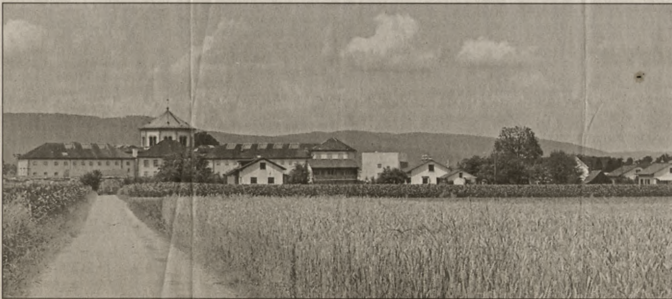
Auf der einen Seite freies Land, auf der anderen Wohnhäuser: Die Strafanstalt Lenzburg befindet sich mitten im Siedlungsgebiet. Foto: do
