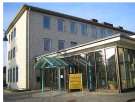
Die Räumlichkeiten der Führungsakademie befinden sich in der Fuhsstraße 30 in Celle
