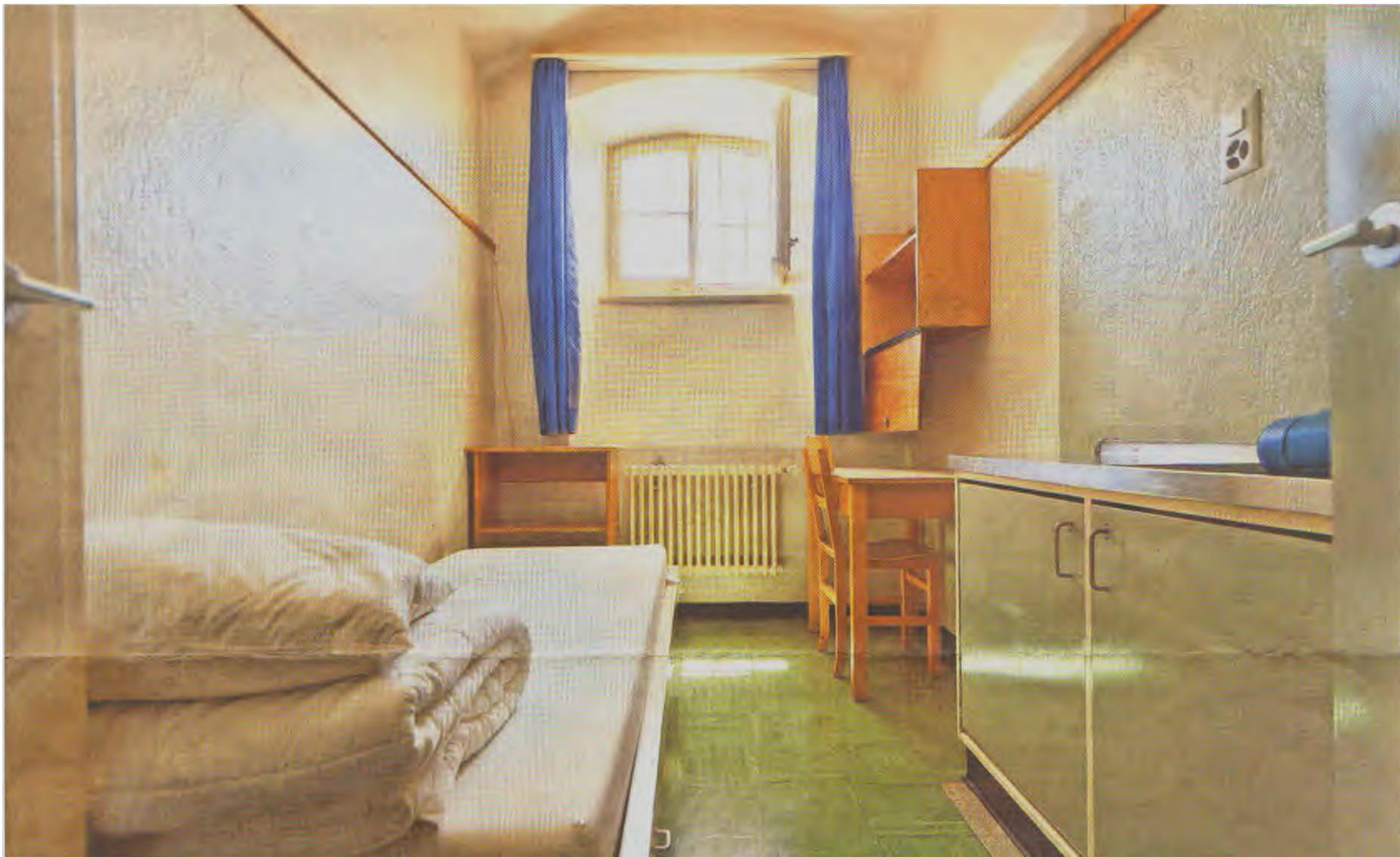
Eine Zelle im Fünfstern-Altbau der Justizvollzugsanstalt Lenzburg. Die Fenster müssen beim Umbau auf 90 mal 132 Zentimeter vergrössert werden, für bessere Sicht und Luft.
