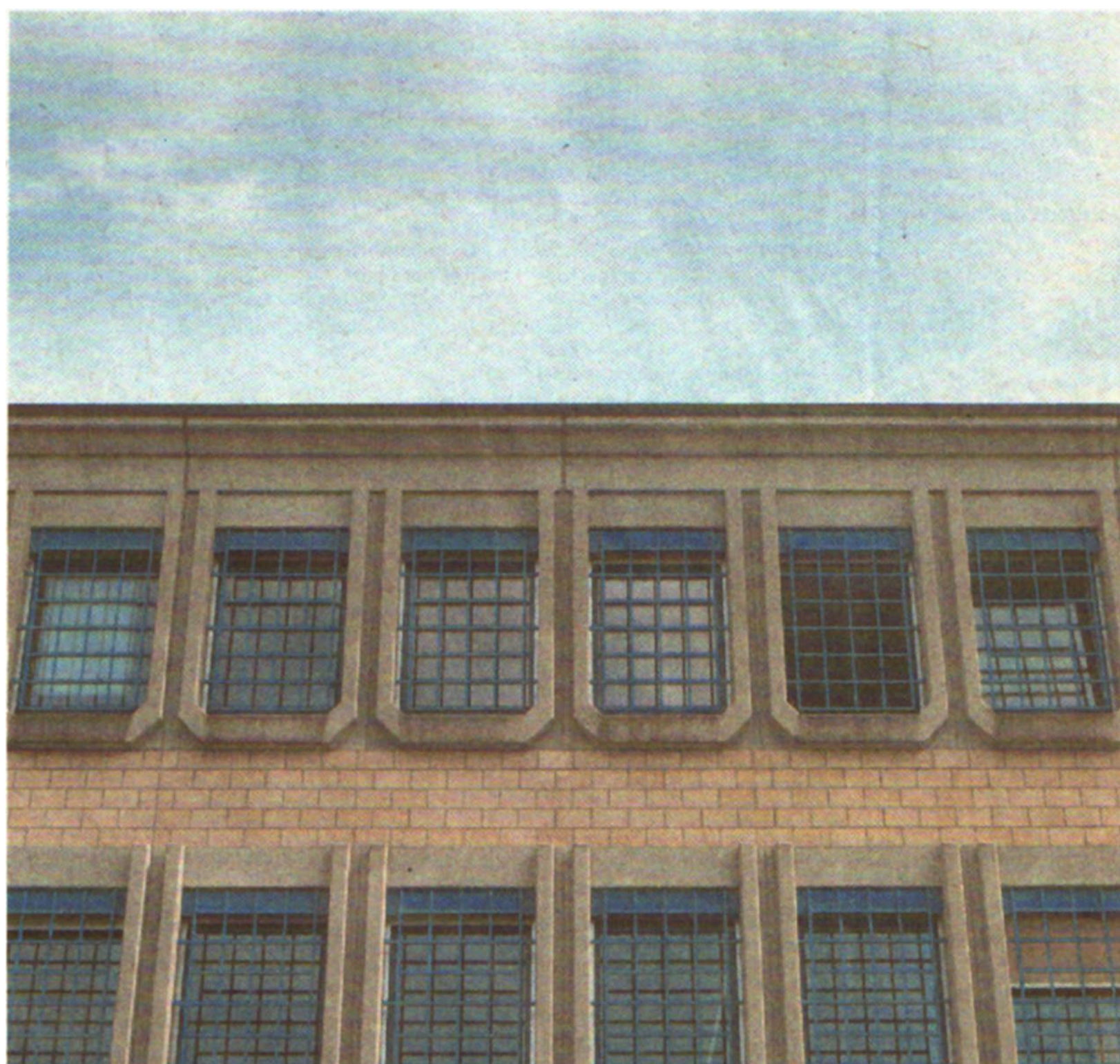
Vergitterte Zellenfenster in der Strafanstalt Pöschwies in Regensdorf
