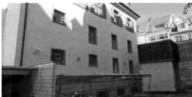
Durch eines der Fenster im Erdgeschoss entkam der Häftling. 20M
