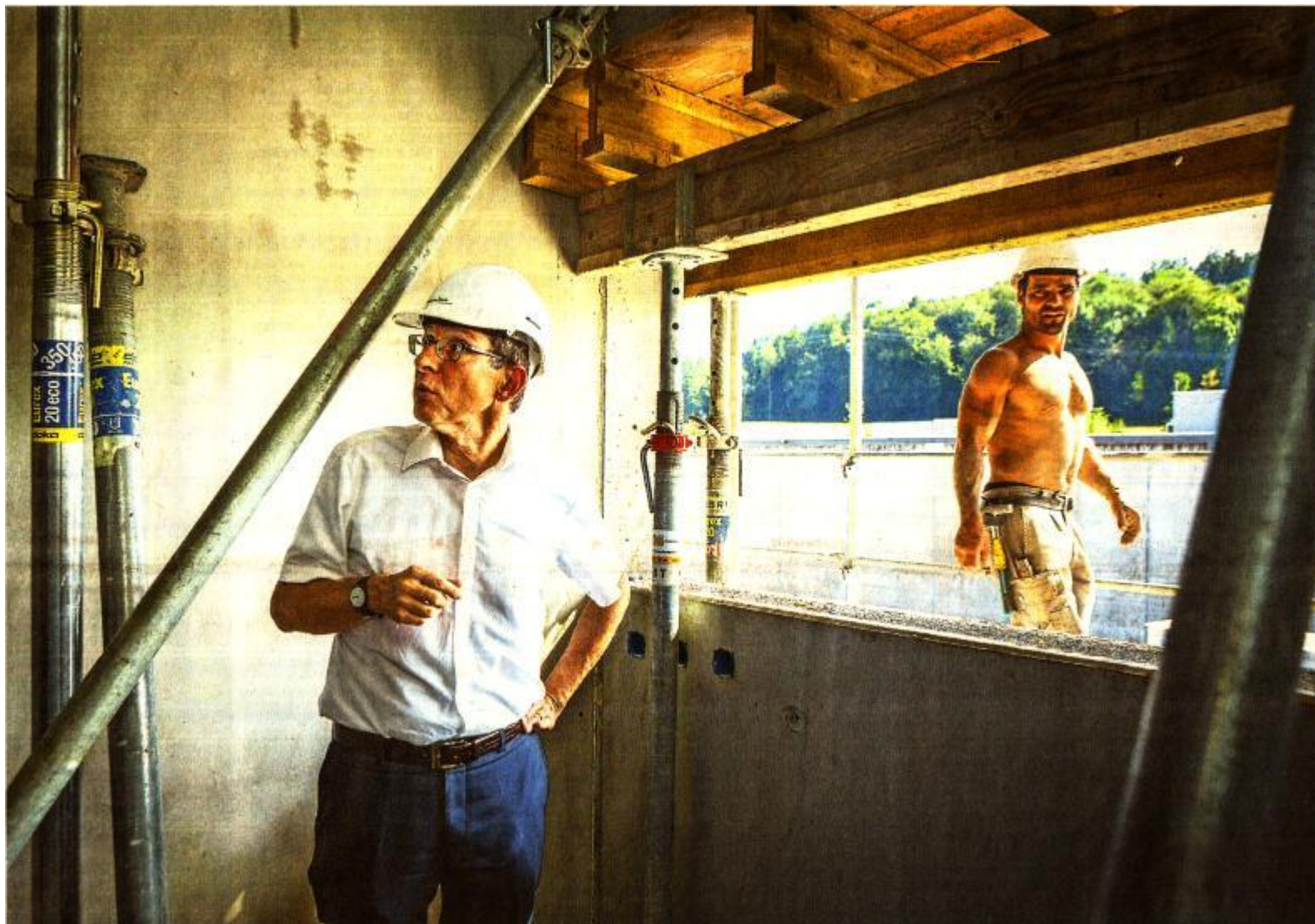
Der Regierungsrat In der Einzelzelle: Justizdirektor Urs Holmann Im Erweiterungsbau des Zentralgefängnisses Lenzburg. 81s zur Eröffnung 2017 laufen die Bauarbeiten auf Hochtouren.
