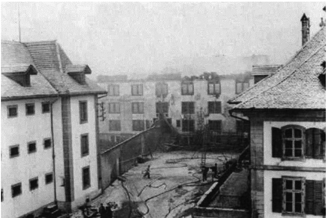
Das Korrektionshaus der Strafanstalt wurde zerstört.
