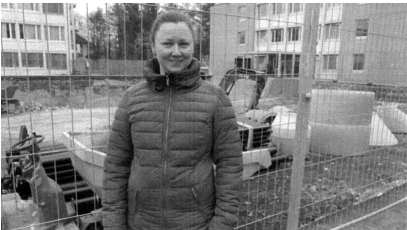
Stationsleiterin Daria Rüegger steht vor der Baustelle des Erweiterungsbaus. Im Hintergrund rechts ist der Altbau.
